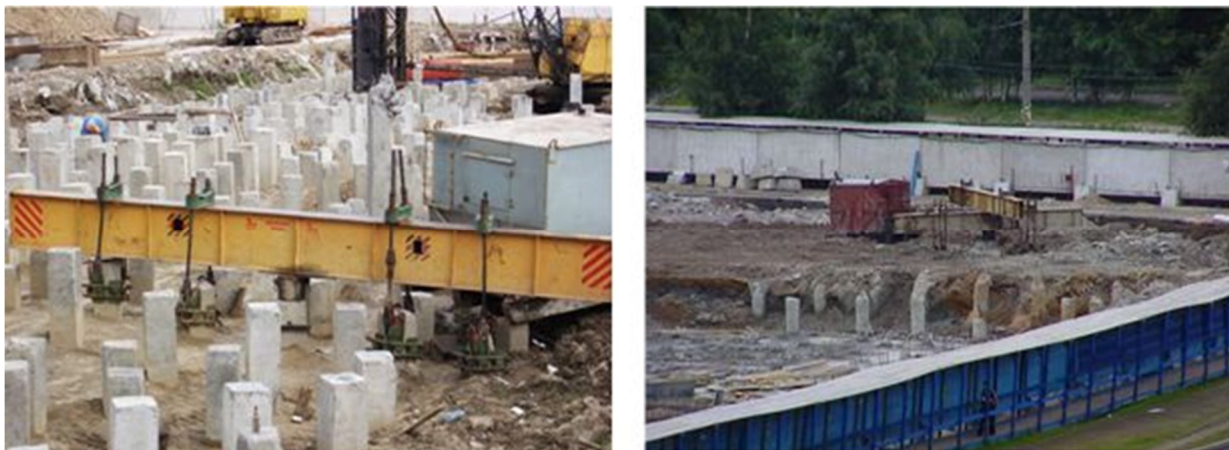
Рис. 8. Фотографии испытательных установок на строительной площадке по определению несущей способности свай статической нагрузкой
