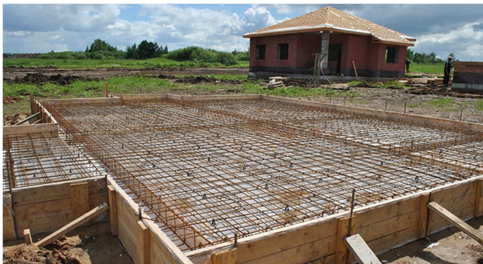
Рис. 10. Плитный ростверк
