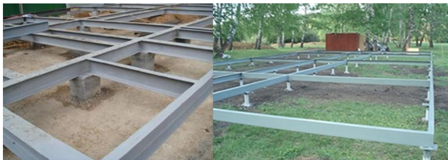
Рис. 1. Металлический ростверк
