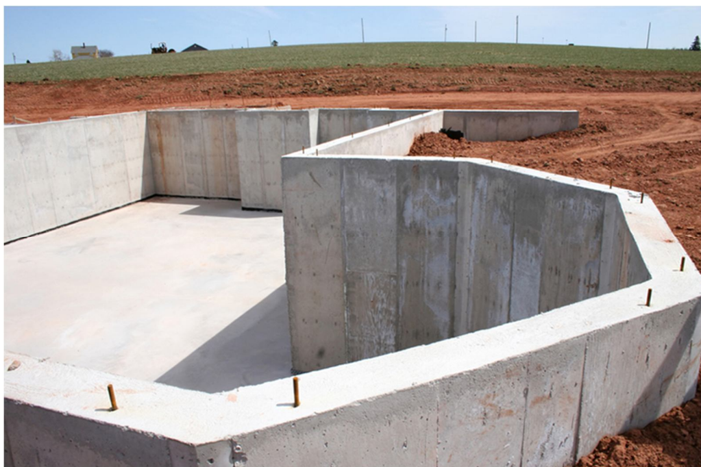
Рис.9. Ленточный ростверк
