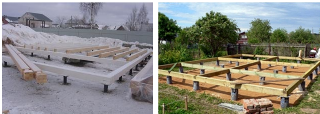
Рис. 2. Деревянный ростверк
